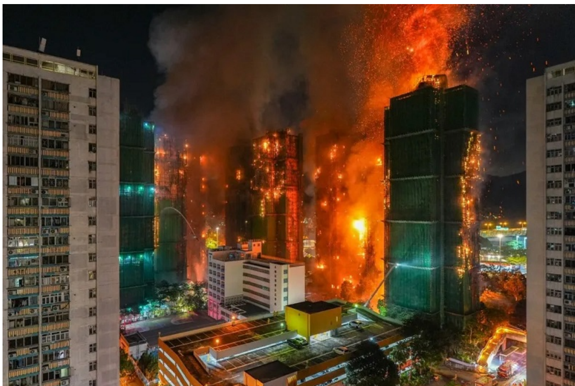
Hình ảnh cháy chung cư ở Hồng Kông. Nguồn: St
